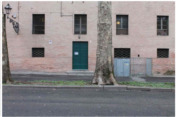
Lato Est Teatro Valli – Accesso uscita emergenza
